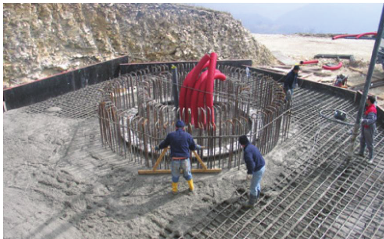
Figura 3.2: Costruzione del basamento di una pala eolica.
